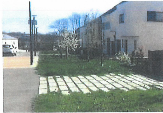
Dalles béton joints enherbées
